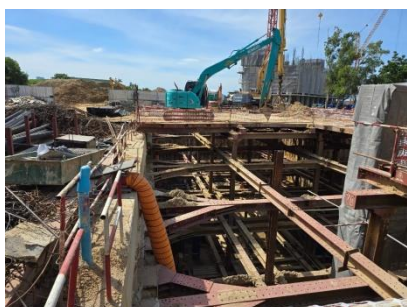
รูปที่ 2.2-5 ระบบป้องกันดินพัง แบบ Sheet Pile ร่วมกับคาน และเสาเหล็ก
