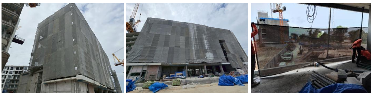
รูปที่ 2.2-27 ผ้าใบกันฝุ่นปิดกั้นรอบตัวอาคาร
