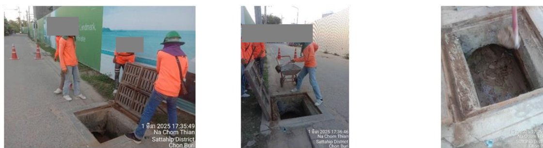
รูปที่ 2.2-18 ขุดลอกตะกอนดิน
