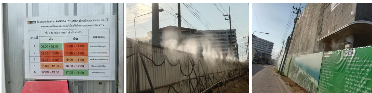
รูปที่ 2.2-28 ระบบสปริงน้ำ เพื่อลดฝุ่นละออง
