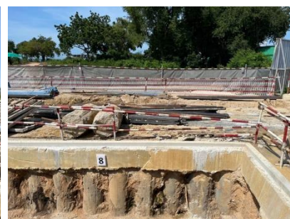
รูปที่ 2.2-5 ระบบป้องกันดินพัง แบบ Sheet Pile ร่วมกับคาน และเสาเหล็ก
